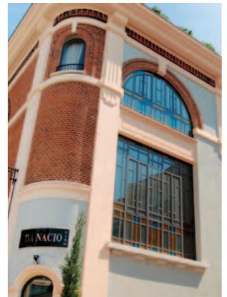
Se non si vuole rinunciare alla resistenza ed all'affidabilità dei serramenti in alluminio, ma per particolari esigenze si desidera avere le finiture del legno, METRA riproduce fedelmente le caratteristiche venature delle varie essenze di legno tramite il processo di sublimazione realizzato sul substrato verniciato.
